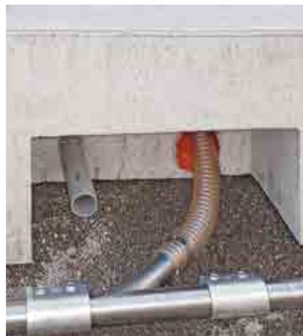
Um Ihnen ein Maximum an Sicherheit zu bieten, können in den Beton-Zwischenriegeln ein Münzabsaugsystem eingebaut werden. Dieses Münzabsaugsystem lässt das Bargeld durch ein unterirdisches Rohrsystem aus Edelstahl in den Technik-Container gleiten. Dort können dann die Bareinnahmen von Ihnen sicher entgegen genommen werden und zum Abtransport gesichert werden.
