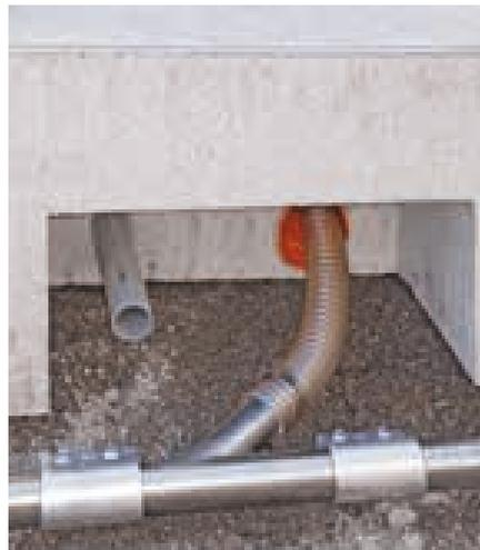
Afin de vous offrir un maximum de sécurité, un système d'aspiration de monnaie peut être installé dans les socles de jonction en béton. Ce dispositif permet à la monnaie d'être transportée au moyen de conduites souterraines en acier inoxydable jusque dans le conteneur technique. C'est là que l'on peut réceptionner l'argent dans le coffre-fort et le préparer en toute sécurité pour son transport.
